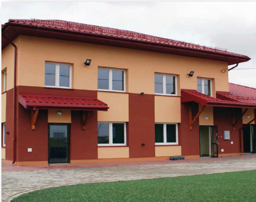
Zdjęcie 21 Świetlica wiejska w Antoniówce
