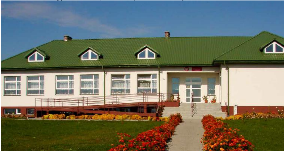
Zdjęcie 18 Budynek Szkoły Podstawowej w Antoniówce
