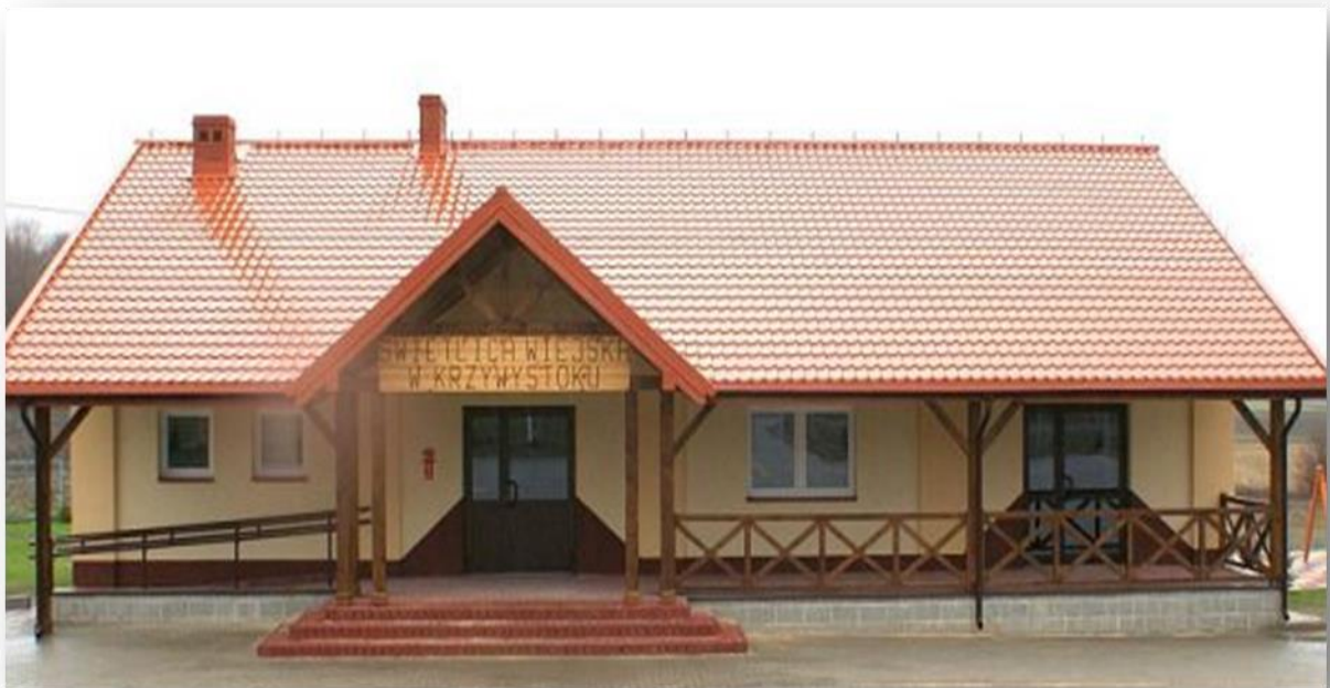
Zdjęcie 19 Zdjęcie 20 Świetlica wiejska w Krzywymstoku (otwarta w 2013 r.)
